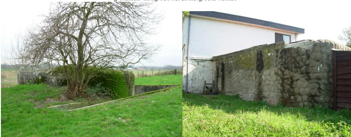
Links: Be5: Perfect ingewerkt in het heuvelachtige terrein van Betsberg. (Foto: www.bunkergordel.be ) - Rechts: De zware bunker A44 te Kwatrecht. Deels gericht op de Schelde en de Kwatrechtsteenweg. (Foto: www.bunkergordel.be ).
