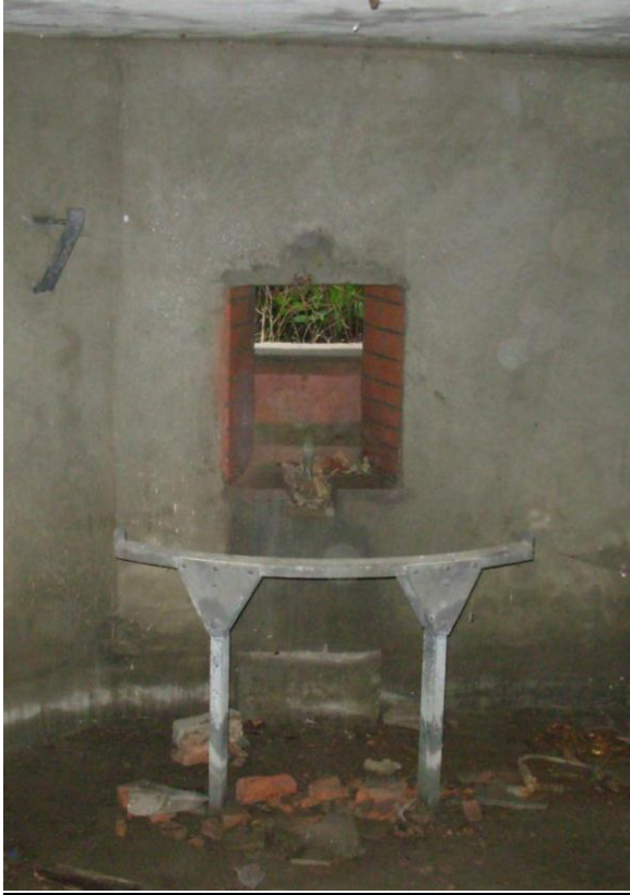
Vrij intacte mitrailleuropstelling, enkel voor Maxim-mitrailleur, verdwenen B46 bunker te Melle.
