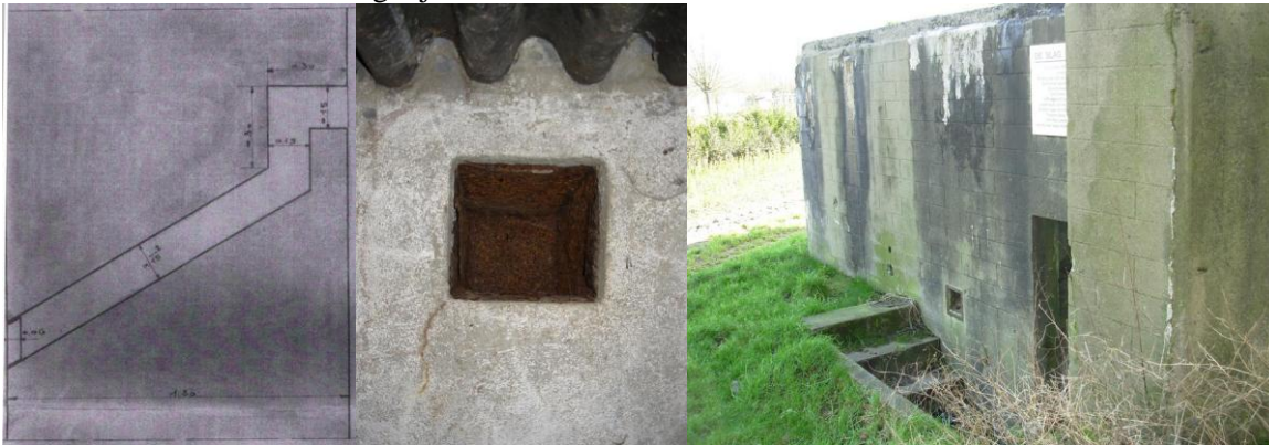
Links: Doorsnede van een granaatwerpgat – Midden: een granaatwerpgat aan de binnenkant van de bunker. – Rechts: Granaatwerpgat bij de bunker A42 te Kwatrecht in de buurt van het toegangssas.
